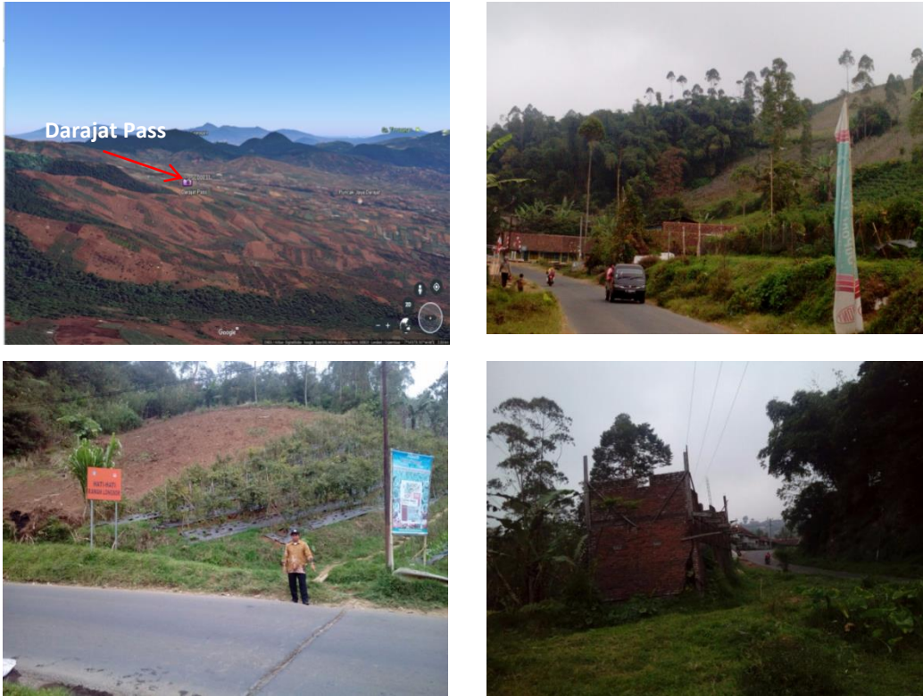
Gambar 4.3 . Lokasi longsor Darajat Pass, berurutan dari kiri atas ke kanan bawah : (1) Alih fungsi hutan lindung menjadi kawasan wisata, perkebunan dan pemukiman. (2) Pemukiman, sarana sekolah dan jalanan ramai di bawah lereng tebing yang rawan longsor. (3) Rambu rawan longsor milik BPBD Garut pada area bekas jalan terbelah akibat longsor. (4) Rumah roboh akibat pergerakan tanah aktif.
